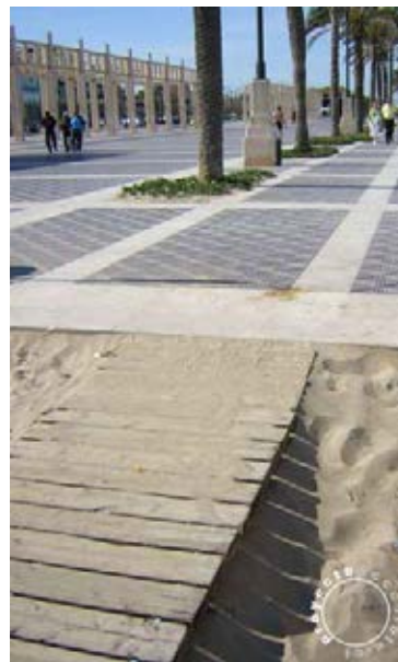
Foto 3: Acceso a playa accesible por pasarela de madera.
